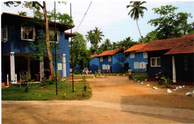
Fotókat Vaskuti Pál készítette a Help Falu felépítéséről.
